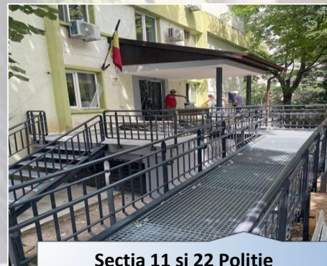
Secția 11 și 22 Poliție reparații scară și rampă persoane cu dizabilități
